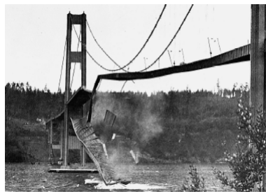
Le pont Tacoma Narrows au moment de la catastrophe.
