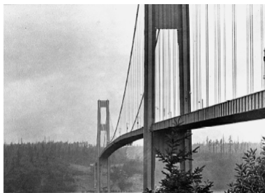
Le pont Tacoma Narrows (au Puget Sound, Washington, USA) au moment où les oscillations ont commencé.
